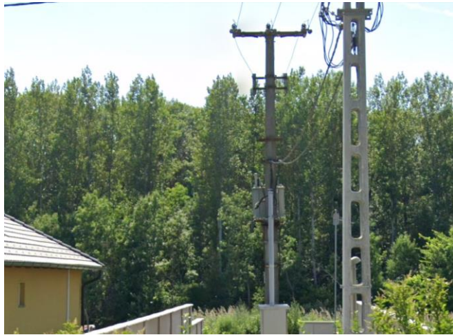
20/0,4 kV-OS OSZLOPTRANSZFORMÁTOR, 20417 SZ. (forrás: maps.google.com)
