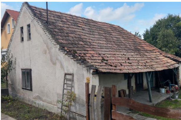
TORNÁCOS, OROMFALAS LAKÓHÁZ A DÓZSA GYÖRGY UTCÁBAN
